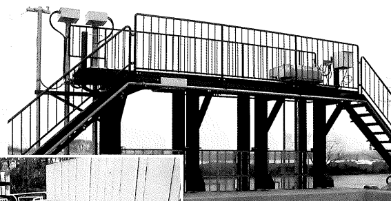
【水道水取水施設】
