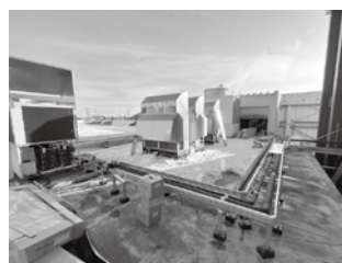
冷媒用多層管設置工事施工例①
