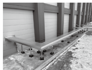
冷媒用多層管設置工事施工例②
